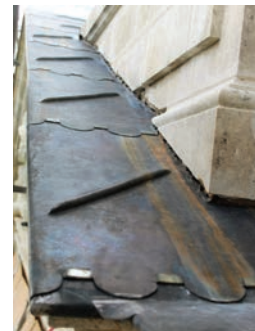
Remparts du fronton Ouest, couverture en plomb.
