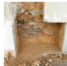
Maçonnerie de blocage derrière le tuffeau
