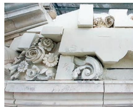
Restauration du fronton Ouest
