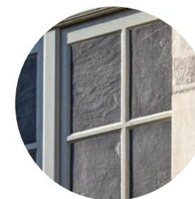
Remplacement du faux vitrage par de l'ardoise
