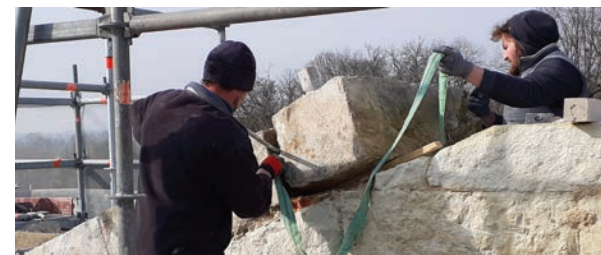
Dépôt des pierres des remparts du fronton Ouest
