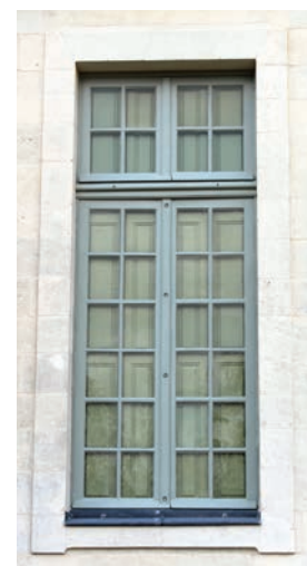
Fenêtre après restauration
