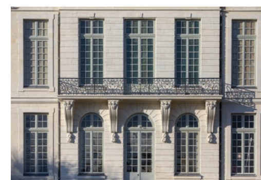
Ferronneries et consoles du balcon Ouest
