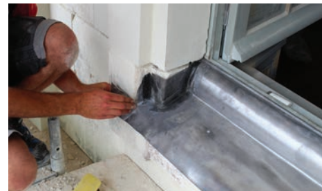
Habillage en plomb d'un appui de fenêtre
